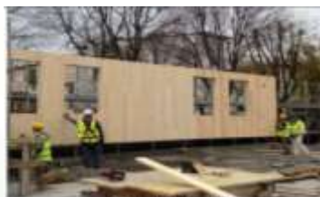
MONTAGGIO PARETE XLAM
