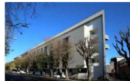
Complesso edilizio completato – Lato Viale Giannotti
