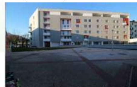
Complesso edilizio completato – Scale A-B-C
